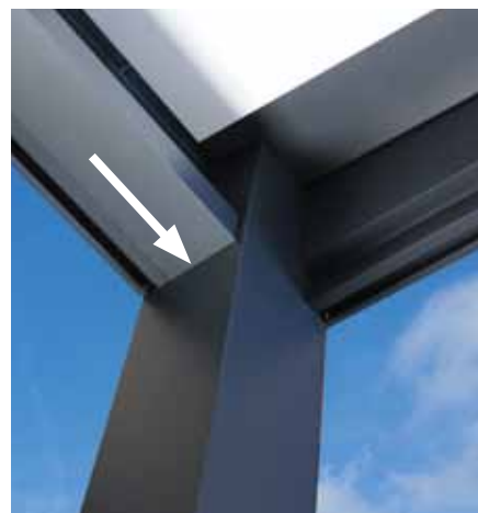
Odvod vody skrze okapy přímo do vertikálních sloupů
